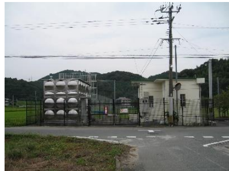
栗田中継ポンプ場
