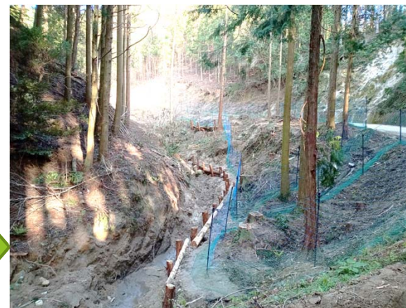
植栽完了状況
