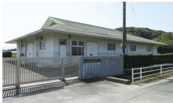
上高場浄化センター
