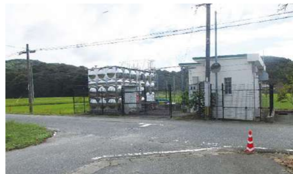
栗田中継ポンプ場
