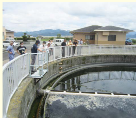
三輪中央浄化センター視察
