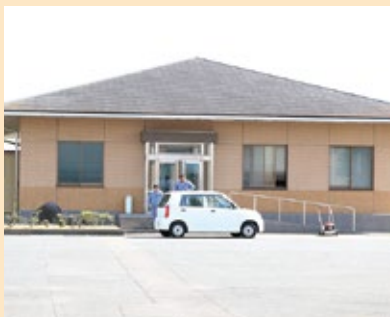
三輪中央浄化センター
