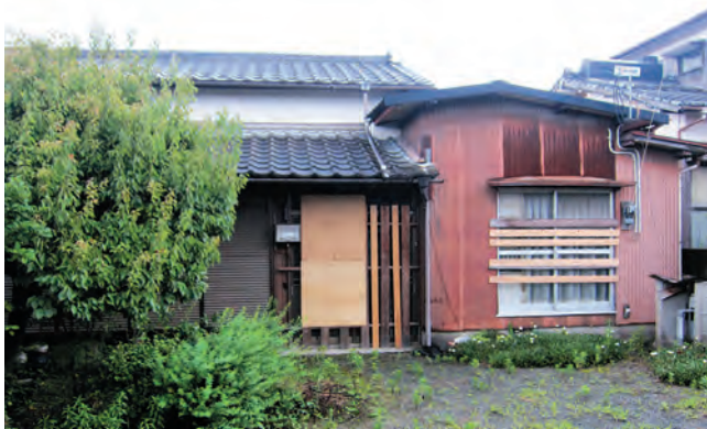
主を待つ空き家
