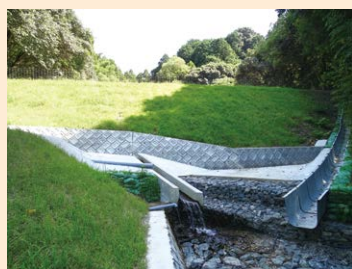
災害復旧完了(地藏谷溜池一帯) 約3,800万円
