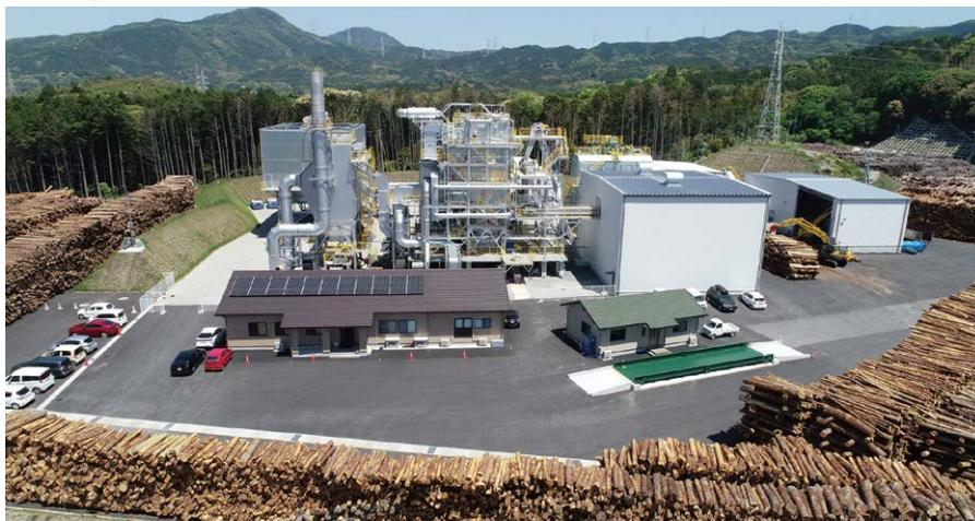
森山区に建設された「ふくおか木質バイオマス発電所」が、いよいよ稼働しました。「バイオマス発電」とは、細かく砕いた木材(チップ)を燃料として発生させる水蒸気ので、タービンを回して発電する方式です。
