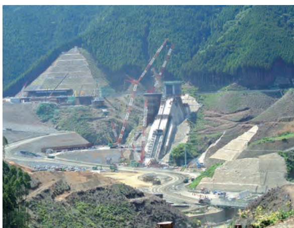
堤高が139m九州一高いダムの建設
