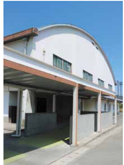
避難所なのにトイレがない体育館
