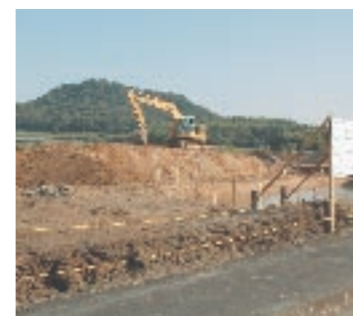
四三嶋地区に造成中の工業用地
