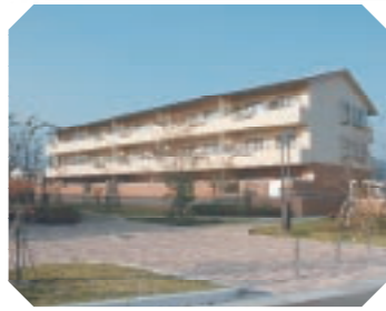
①町営住宅建替工事 8億9,049万円
