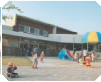
⑥篠隈保育所改築工事 3億6,305万円
