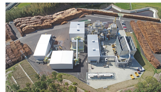
上空から見たバイオマス発電所
