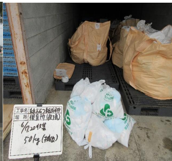
▲組成調査及びフレコンによる保管状況
