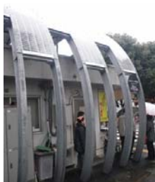
●ソーラードーム
