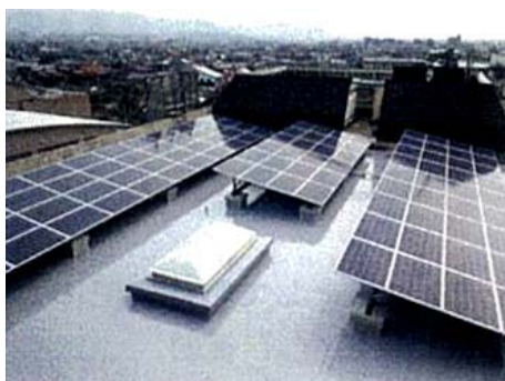
■本庁舎屋上 30kW 設置
