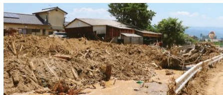
■朝倉地域集中豪雨による被害 (2017年(平成29年)7月)
