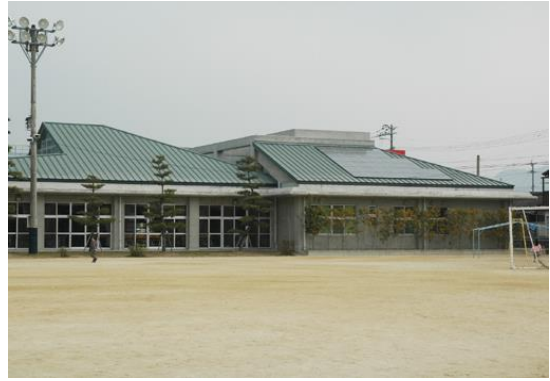
■三輪小学校の太陽光発電システム
