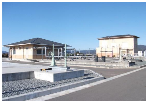
■三輪中央浄化センター
